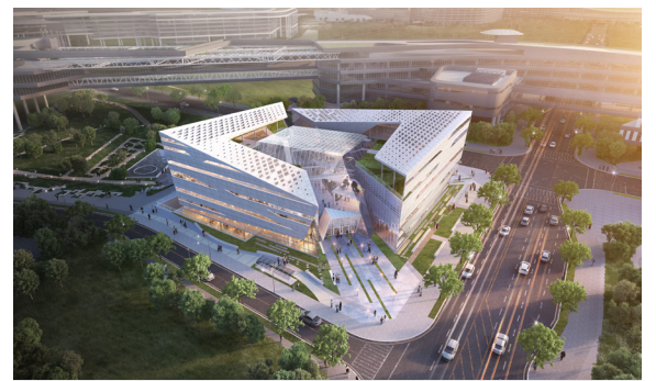
복합편의시설 제2공사 (복합문화시설)
