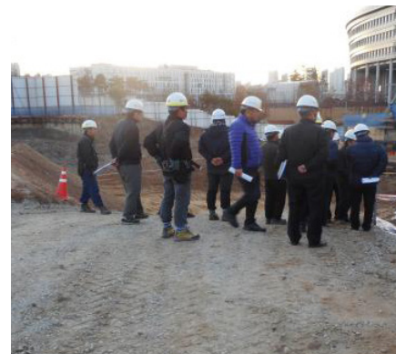
공공건축 건설현장 점검
